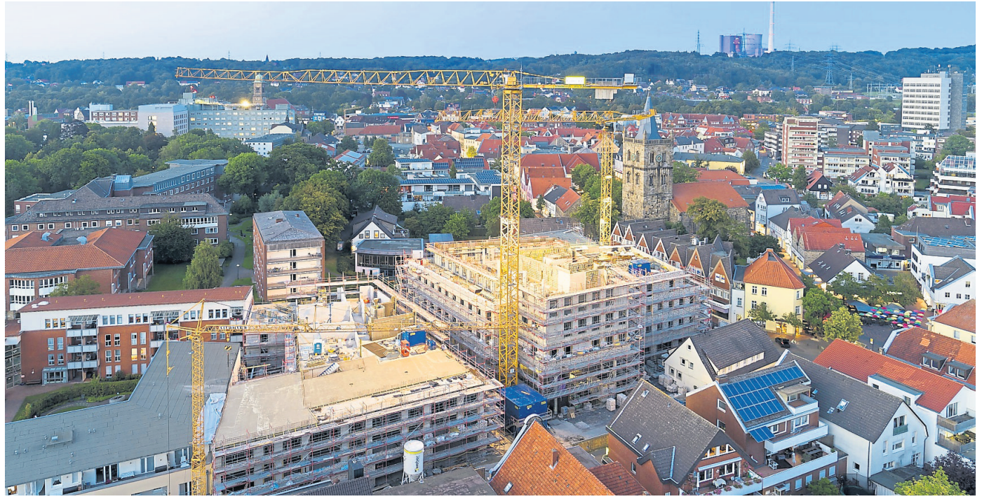
Der Bau des Medienquartiers für die IVZ/IVD-Unternehmensgruppe in der Ibbenbürener Südstadt ist derzeit das größte innerstädtische Hochbauprojekt des Bauunternehmens BÖRGEL.
