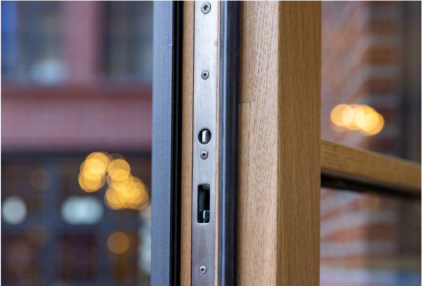
Details, die die Philosophie des Verlages erlebbar machen: Die gewählten Holz-Aluminium-Fenster im Erdgeschoss sind mit ihrer Höhe von vier Metern eine Sonderkonstruktion und fügen sich mit ihrem filigranen Industriedesign perfekt in das Erscheinungsbild des Speichers ein.
