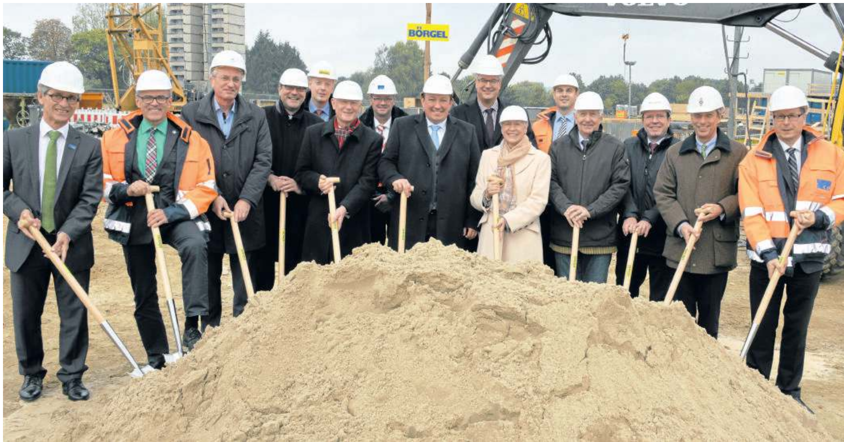
Gleich geht es los: Die Szene kurz vor dem symbolischen Spatenstich für die Neubaumaßnahme von Crespel & Deiters in Ibbenbüren. Es ist die größte Investition in der 158-jährigen Firmengeschichte.
